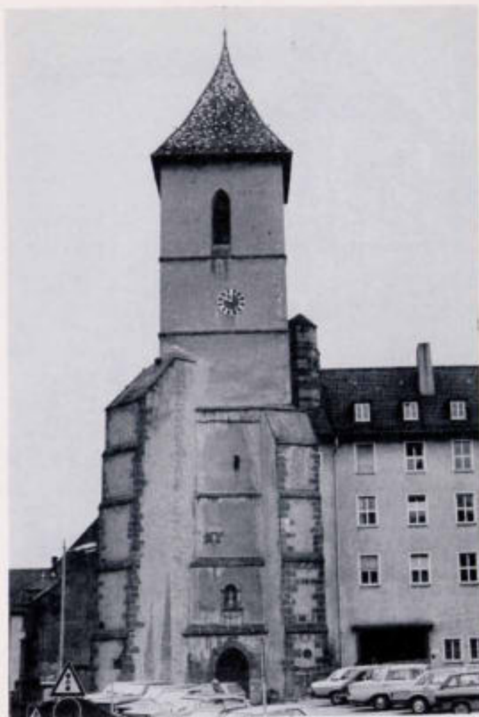
Westfassade mit Turm
