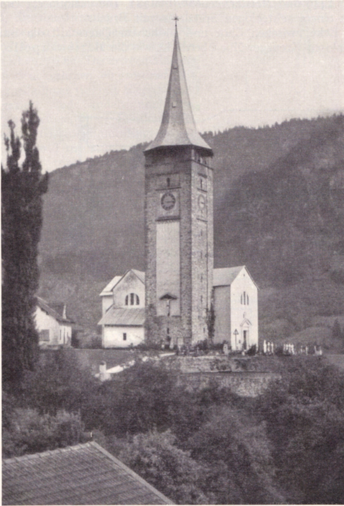
Abb. 109. Sagens. — Die Katholische Pfarrkirche St. Mariä Himmelfahrt. Ansicht von Nordwesten.
